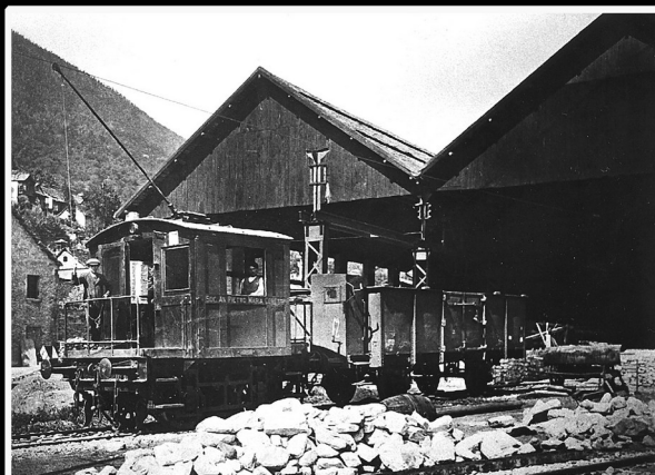
1920 - Locomotore elettrico, importato dall'America (San Francisco). Serviva per il trasporto tra la ferriera, l'acciaiera e la stazione FS.
